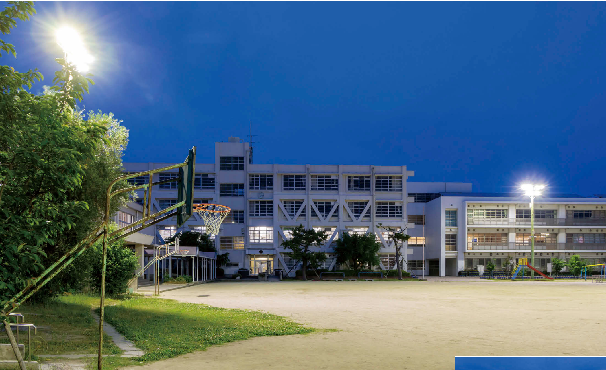
グラウンドの照明風景 発光面をほぼ真下に向けて設置して器具前方のグラウンドを照らす前方広角配光タイプのLED投光器①を採用1kW形金属ハイドランプ器具相当の明るさで、既設同等の150ルクスを超える平均照度を実現
