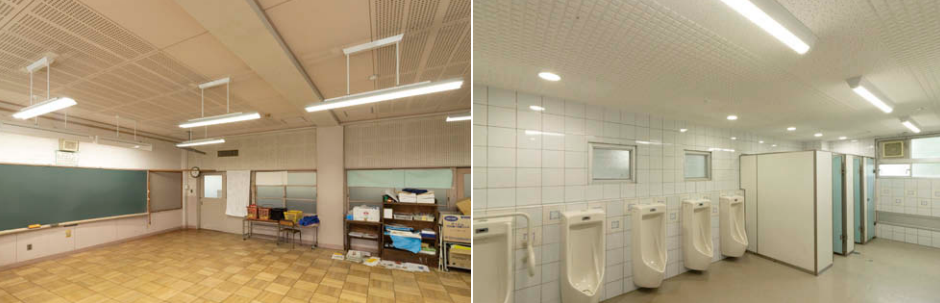
北校舎3階学習室の照明 直付形 反射笠タイプのLEDベースライト③をパイプ吊りで設置 北校舎2男子トイレの照明 LEDベースライト防湿・防雨形④とLEDダウンライト⑤に更新
