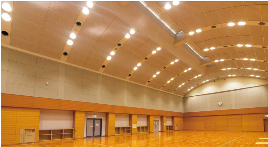
サブアリーナの照明 メタルハライドランプ器具からLEDダウンライト⑤に更新
