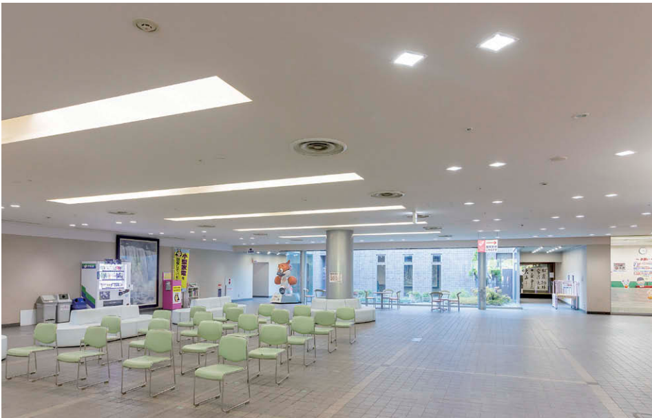
メインロビーの照明 玄関口につながるロビーは照明LED化により明るく開放的な空間へと変貌
