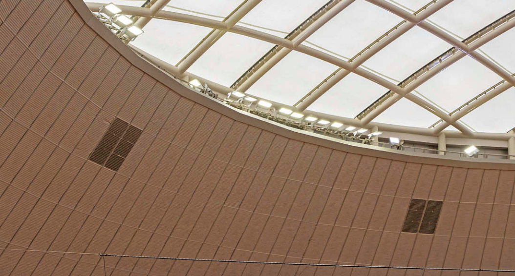
メインアリーナの器具配置 競技中の利用者に眩しさを感ぜないようにLED投光器①②を目線延長上に設置しないように設計
