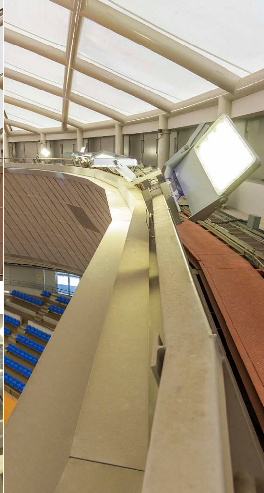
(上)メインアリーナ天井の間接照明 ガラス繊維膜の天幕に光を当てるLED投光器②③
