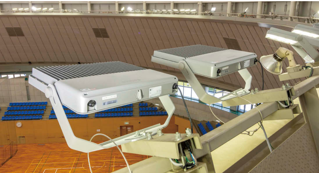
メインアリーナの器具配置 競技中の利用者に眩しさを感ぜないようにLED投光器①②を目線延長上に設置しないように設計
