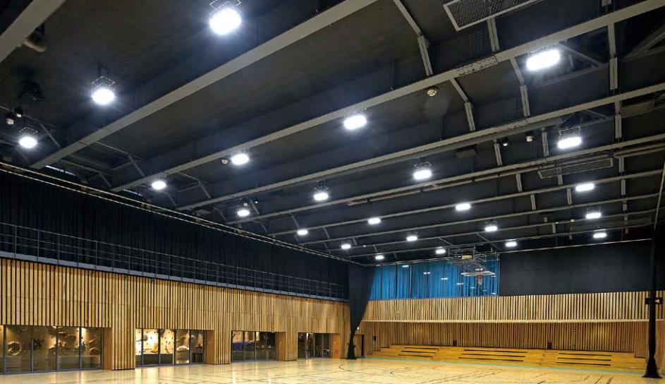
サブアリーナ まぶしさ低減タイプのLED高天井器具③を採用し下面ガードを装着
