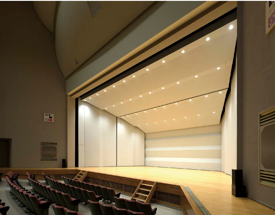
音響反射板 LEDシアターシリーズダウンライト①を採用し既設器具位置に配置
