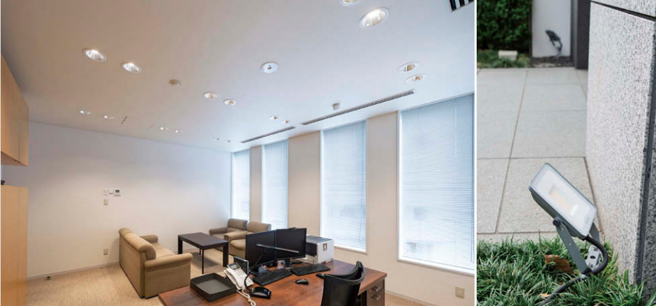
5階社長室の照明 電球色のLEDダウンライト③を18台採用
