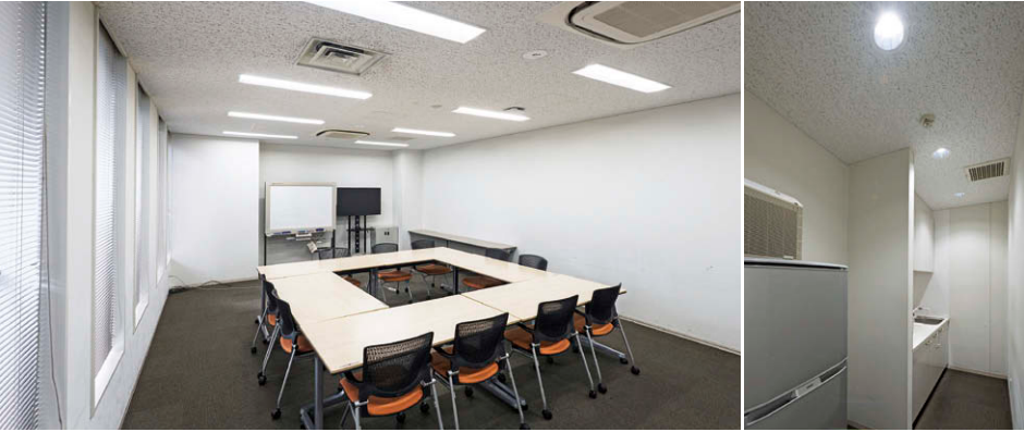
3階事務室の照明 LEDベースライト①を計29台設置 フロア一括点灯時を50%調光に設定し節電
