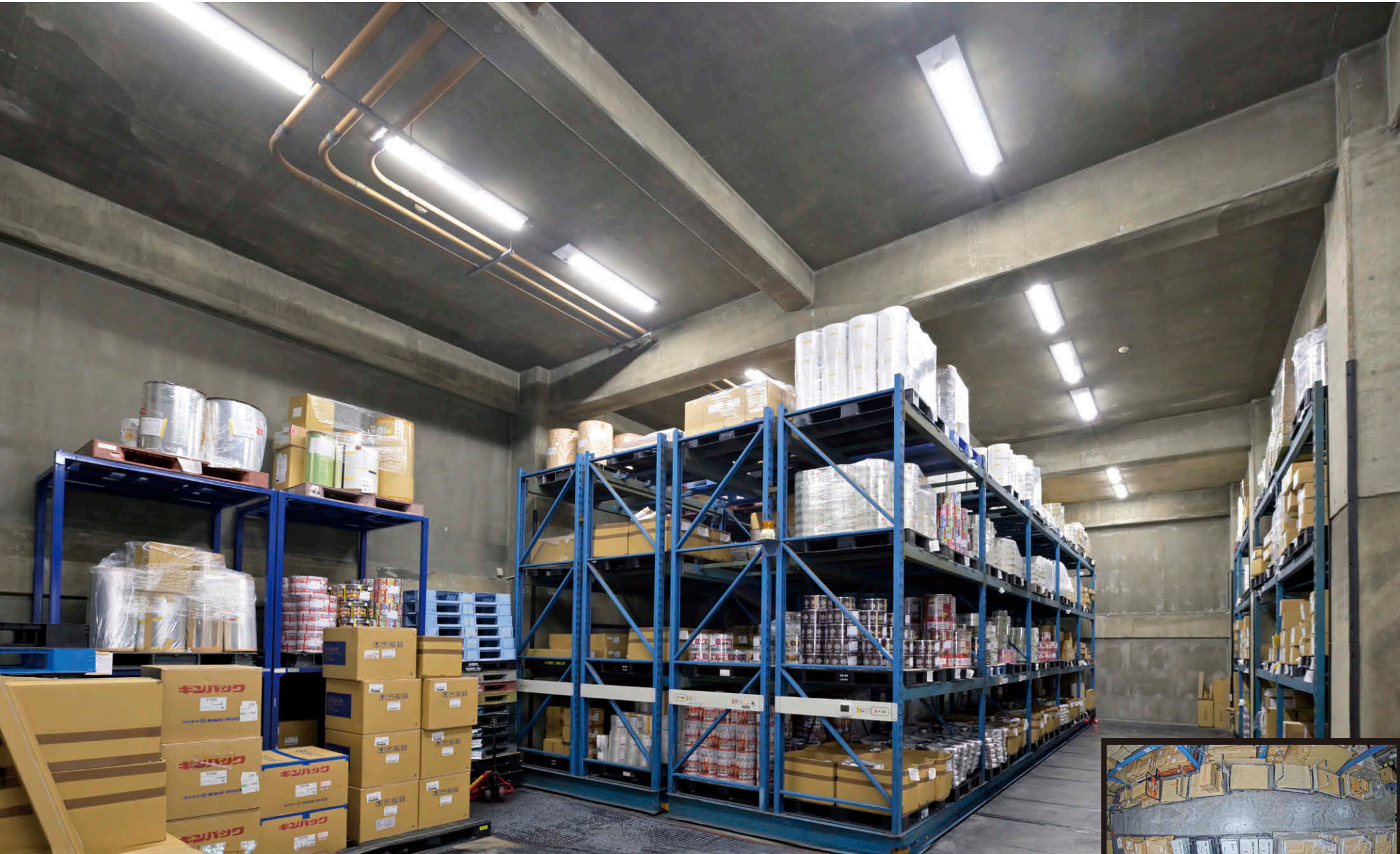
1階倉庫のViweLED 高さ5.5mの天井に設置されたベースライトのうち3灯に5,200lmタイプのViewLEDベースライトタイプを採用 広範囲をカバーする死角の生じにくい俯瞰映像により状況確認が可能(右下：カメラ映像)
