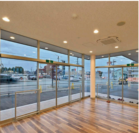
1F ATMコーナー LEDユニット交換形ダウンライト(温白色)④による照明
