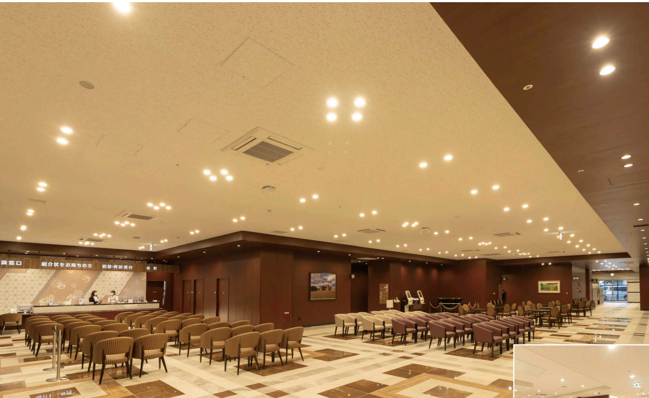
1階エントランスホールの照明 天井折り上げ部には4灯または2灯を1組とした白色反射板のLEDダウンライト①を計105台配置 周縁部の下げ天井には黒色反射板のLEDダウンライト②を22台配置
