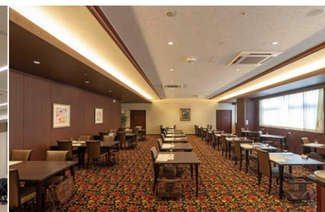
12階レストランの照明 内装に合わせてLEDダウンライト①②とLEDライン器具⑨を採用
