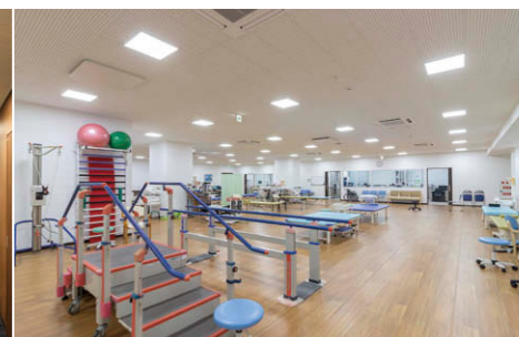
12階リハビリテーション室の照明 高さ3mの天井に47台のLEDスクエア器具⑤を整列配置
