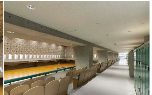
中2階の照明 観客席とロッカーのある中2階通路にLED一体形ダウンライト③を採用
