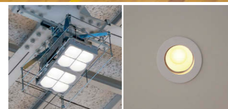
(左) LED高天井器具(落下防止ワイヤー標準装備) (右) LEDシアターシリーズダウンライト
