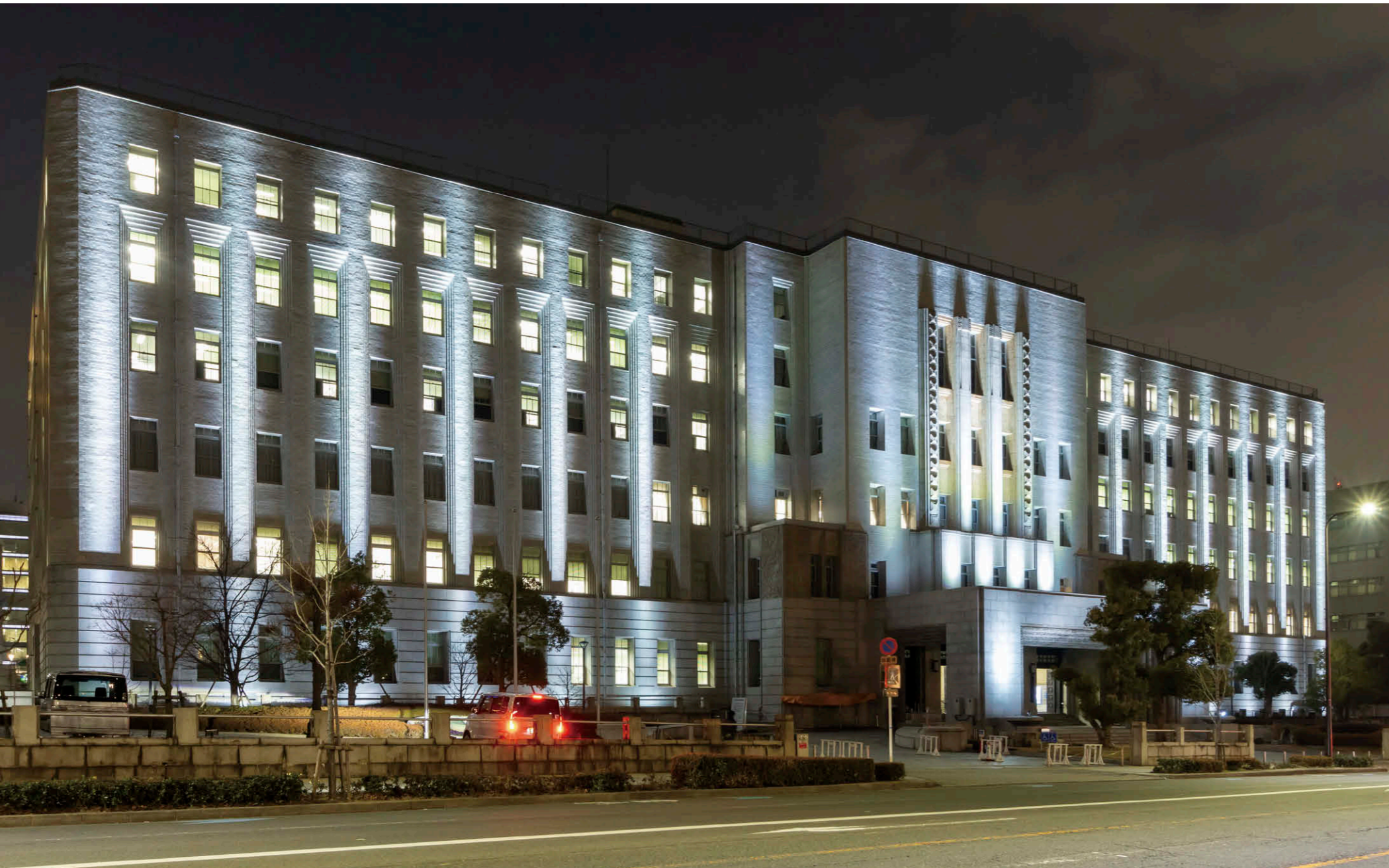
ライトアップ常時点灯(白色) フルカラーLED照明器具①が下方から上方へ大きな「面」を照射しスポットライトタイプの②が細部を照射
