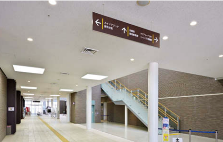
1階エントランスロビー 高効率タイプのLEDダウンライト⑥とイト⑥と埋込形□1257のLEDスクエア器具④を採用
