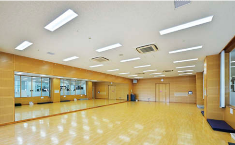
1階軽運動室 明るい21台のLEDベースライト⑥により視認性の高い空間を創出
