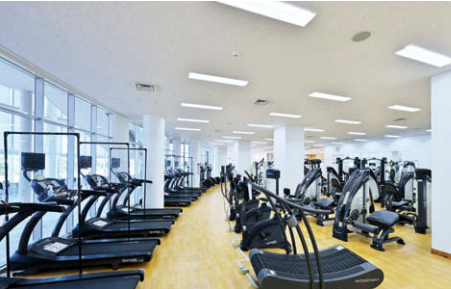
1階トレーニング室 6,900lmタイプの埋込形LEDベースライト⑤を採用
