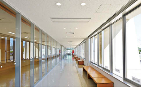
1階廊下 外光に配慮してLEDダウンライト非調光タイプ⑥と調光タイプ⑦を交互に配置
