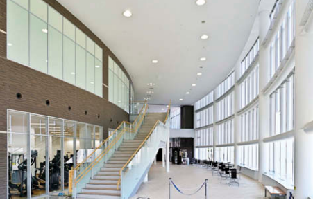
1階談話コーナー リニューアルプレートを利用して吹き抜け部の高天井ダウンライト⑨13台を更新
