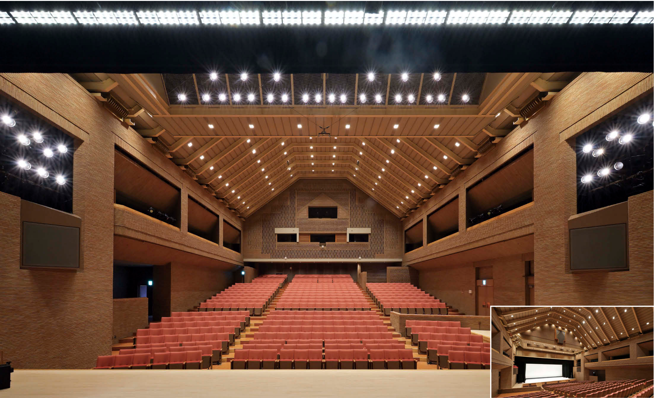
ホールの照明（舞台側から） 舞台照明はLEDスポットライト①②③④およびフルカラーLEDボーダーライト⑦を採用 530席のホール客席の照明はハロゲン電球と同じように色温度が変化するLEDシアターシリーズダウンライト⑧⑨に更新
