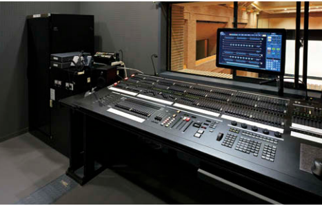
調光室 複雑な照明演出を容易に実現できる調光操作卓LICSTAR-V TypeJを導入
