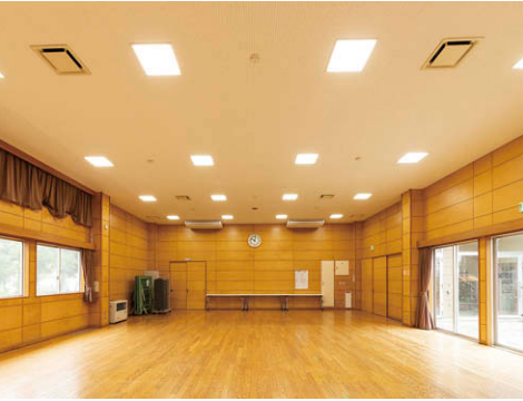
松陵学区コミュニティ防災センター(防災集会室) LEDベースライトTENQOOスクエア⑤を採用
