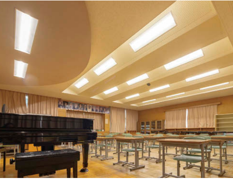
亀ヶ崎小学校(音楽室) 学校施設では空間に合わせてLEDベースライトグレア抑制タイプ④を採用
