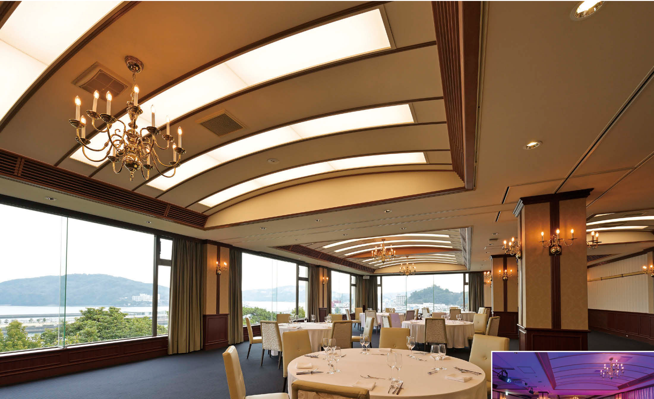
ハーバーウイング/5階宴会場「潮騒」の照明 天井折り上げ部の建築化照明は既設の蛍光灯器具に代えて調光調色照明器具①を採用 周縁部のダウンライトは白熱ランプ器具からLED器具②へリニューアル
