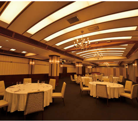
宴会場「潮騒」の照明シーン例 建築化照明には直付形の調光調色器具①144台を使用してさまざまな照明環境を創出(左/電球色パターン 右/昼白色パターン)
