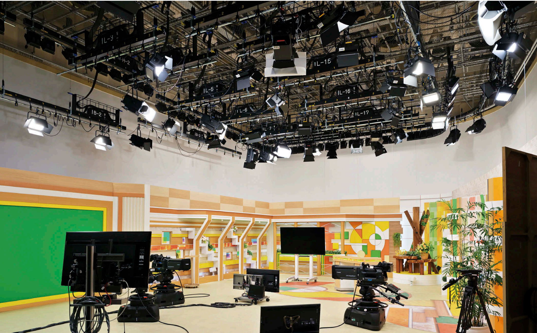
スタジオ全景 セットと撮影位置に合わせてLEDスポットライト①、LEDフラッドライト②、LEDブロードライト③を設置
