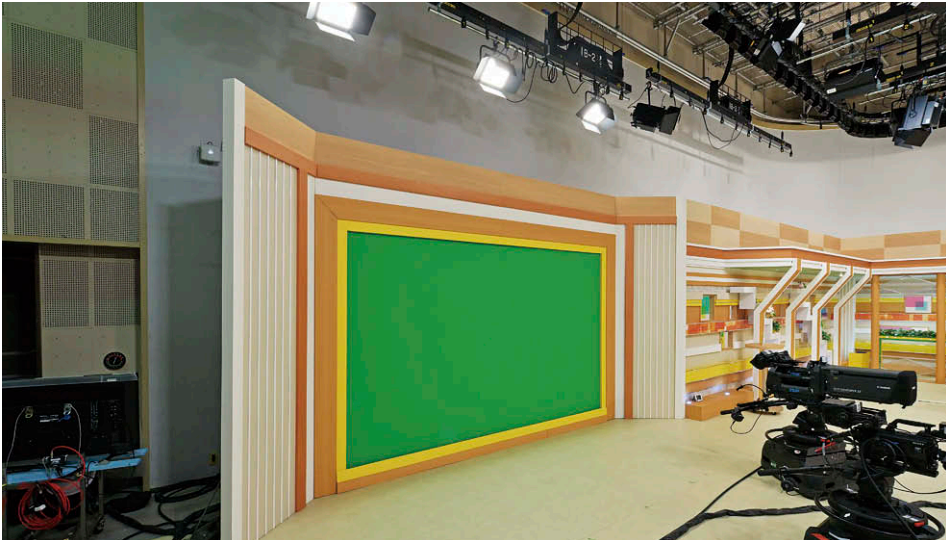
クロマキーエリア 出演者にLEDスポットライト①を当て上方からはLEDフラッドライト②③を照射
