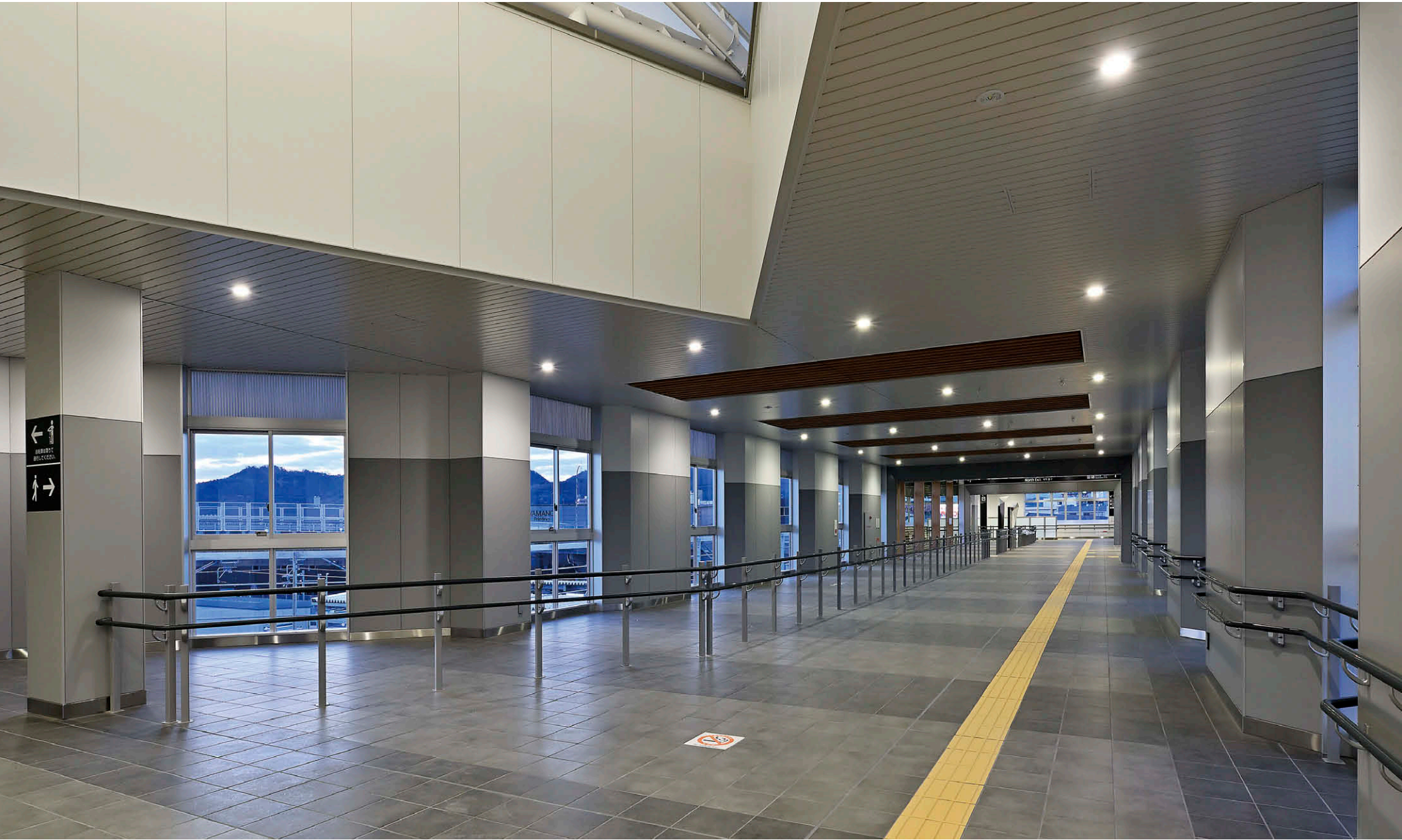
自由通路 無線照明制御システム「LinkLED Air」に対応したLED交換形ダウンライト①②により時間帯や外光に合わせて光環境を24時間自動制御
