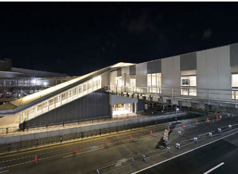
手柄山平和公園側階段幕天井 LED屋内用ライン器具⑤により幕天井を照射し存在感を演出
