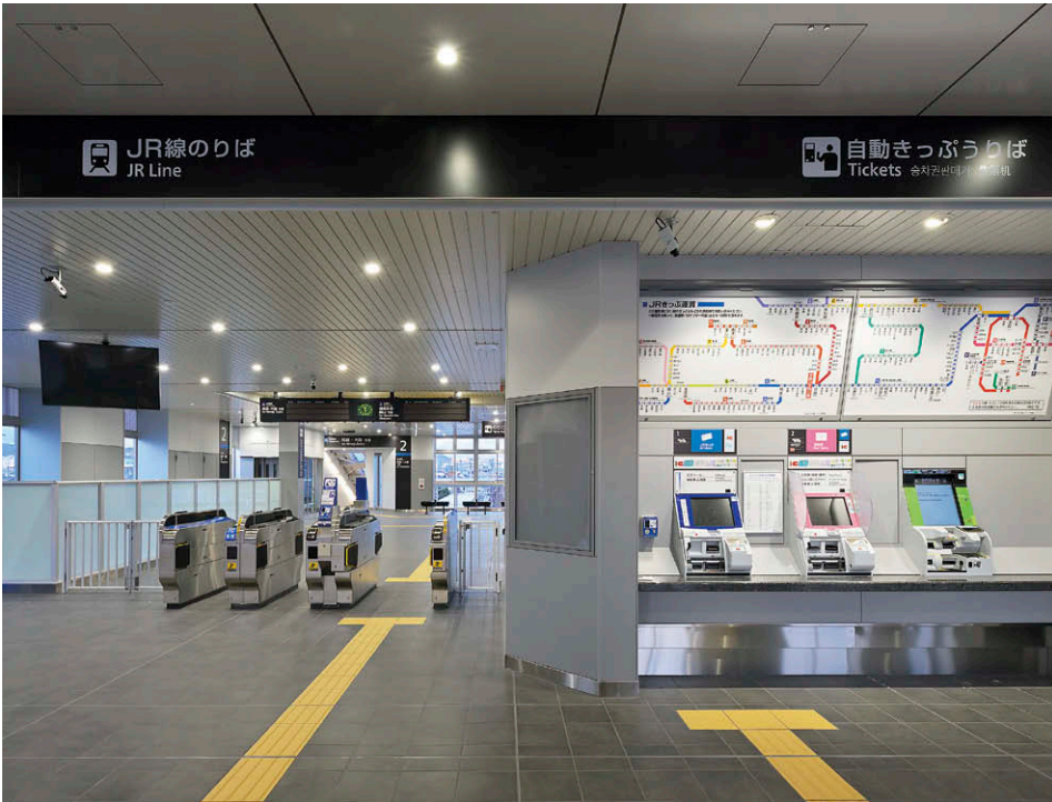
券売機 光軸の照射角度を綿密に設計し超広角タイプのLED一体形ユニバーサルダウンライト④を採用
