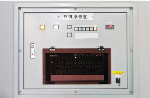
③照明操作盤 (左) カバーを閉じた状態(右) カバーを開いた状態
