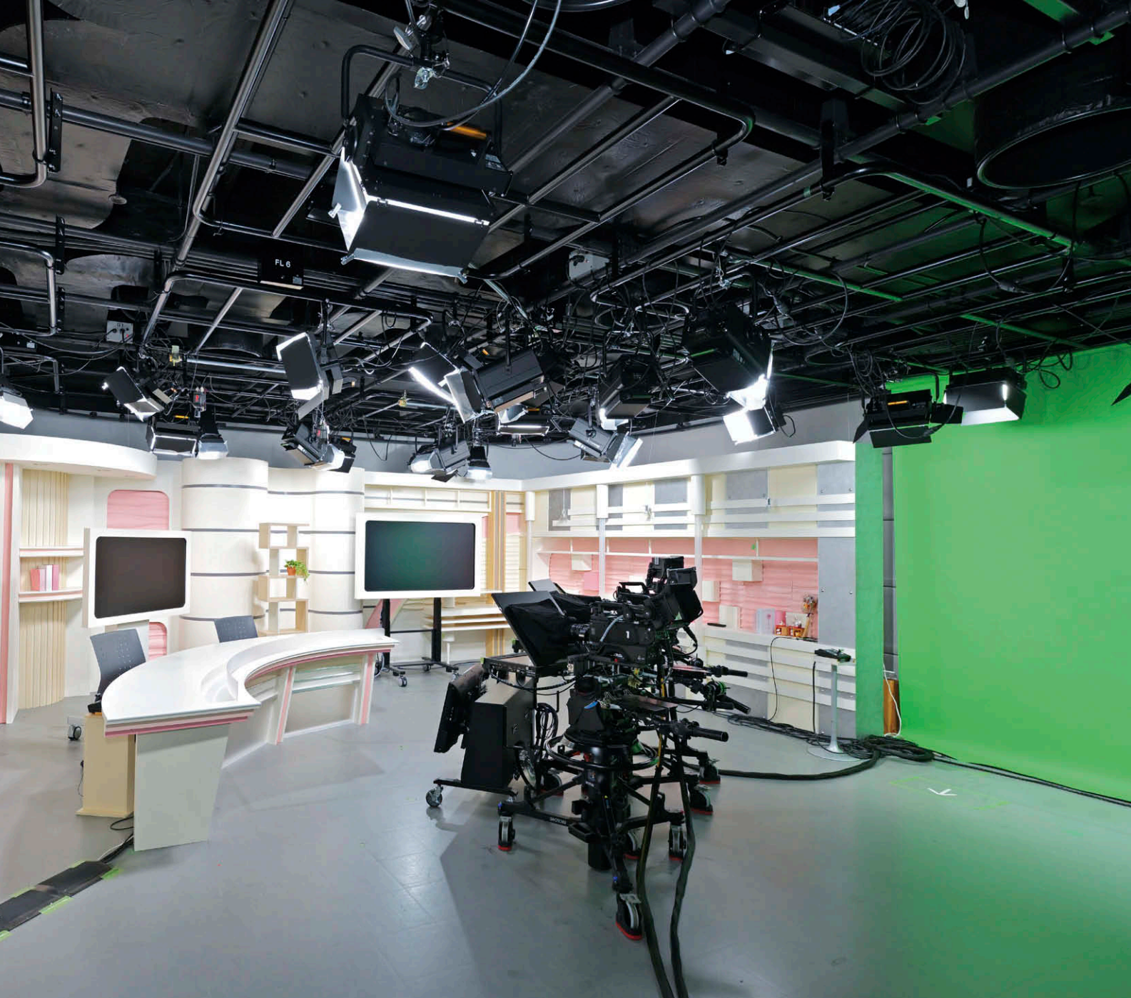
ニューススタジオ全景 セットと出演者の立ち位置に合わせてLEDフラッドライト①、LEDスポットライト②を配置
