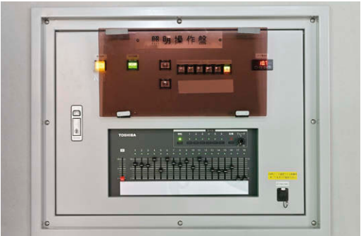
③照明操作盤 (左) カバーを閉じた状態(右) カバーを開いた状態
