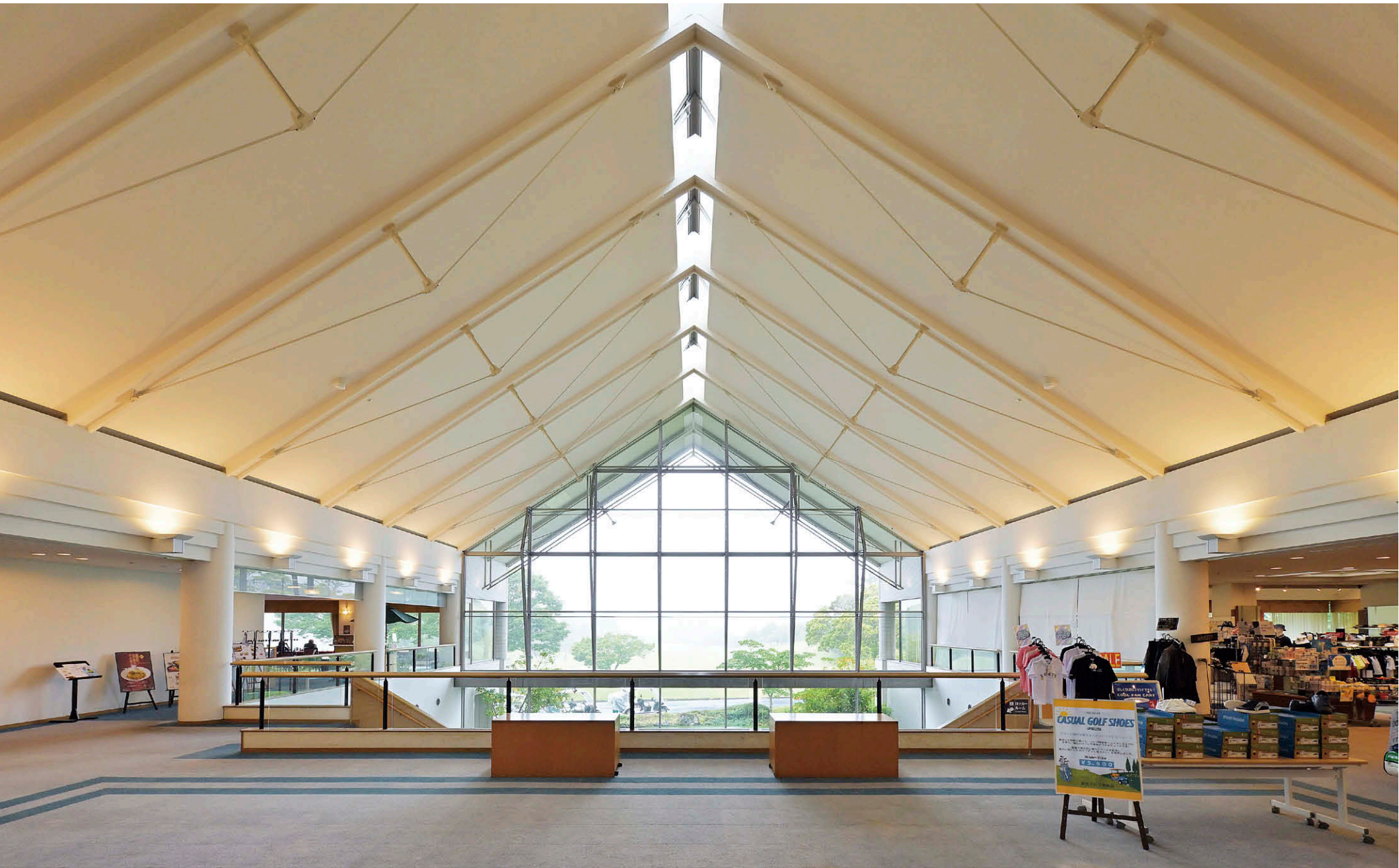
2F ロビー LED小形投光器⑤とLEDダウンライト⑥による照明
