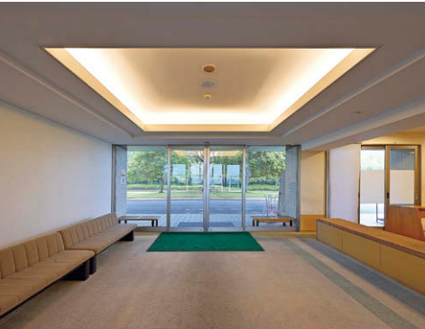
2F エントランス 折り上げ天井に設置したLED屋内用ライン器具②
