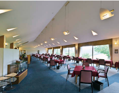
2F ダイニング LEDユニット交換形ダウンライト④とLED電球⑦による照明
