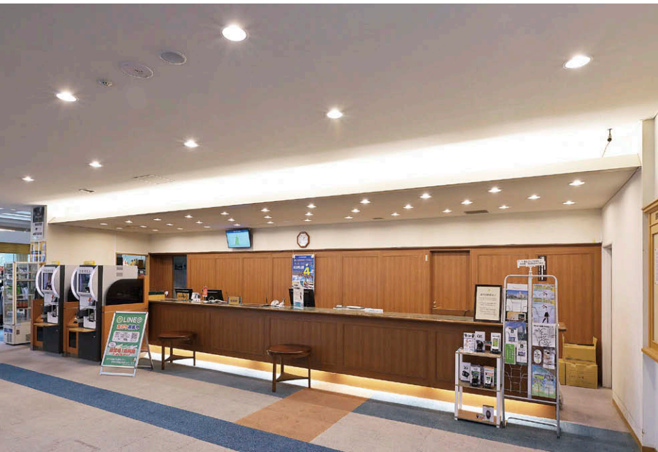
2F フロント LED屋内用ライン器具②とLEDダウンライト③による照明
