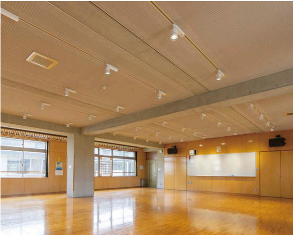
2F多目的室 LEDスポットライト⑥による照明
