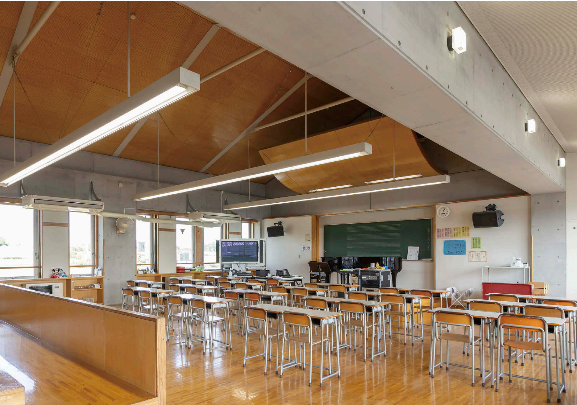
3F音楽室 LEDベースライト①とLEDユニットフラット形屋外用ブラケット④による照明
