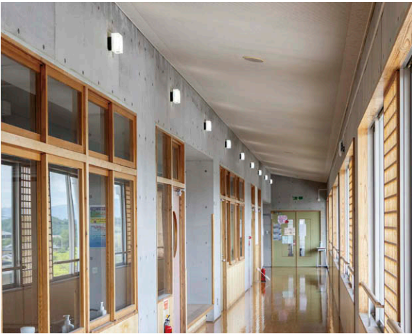
3F廊下 LEDユニットフラット形屋外用ブラケット④による照明
