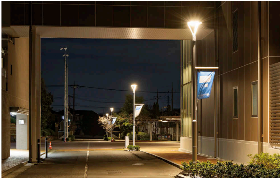
駐車場側から車両門方向を望む LED街路灯全周配光タイプ①を車両門から駐車場にかけて設置
