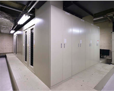
主幹調光器盤は調光ユニットを一部直ユニットに交換
