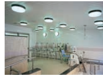
浴室 Bath room 明るく清潔な雰囲気をつくり出している
