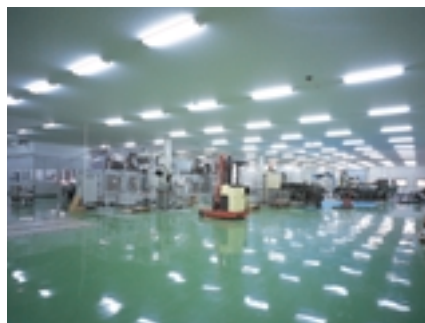
オフセット輪転機のある工場内は32W紫外線吸収膜付蛍光灯2灯用逆富士形器具で印刷物の退色防止に配慮している
