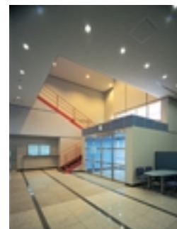
エントランスホールは吹抜け部に150W高圧ナトリウムランプ埋込ダウンライトを、その他には27Wユーライン蛍光灯ダウンライトが使用されている
