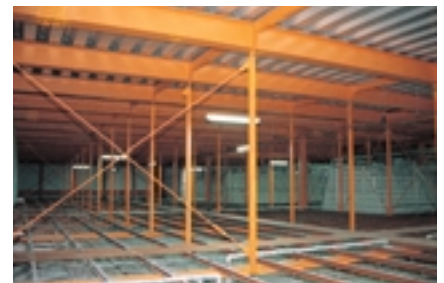
工場天井裏にあるキャットウォーク
