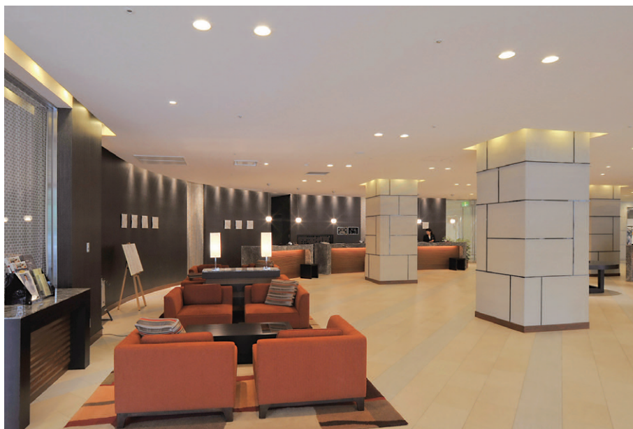
1階エントランス・待合スペース 長時間点灯するため、LEDダウンライト900シリーズの効率重視タイプを採用
