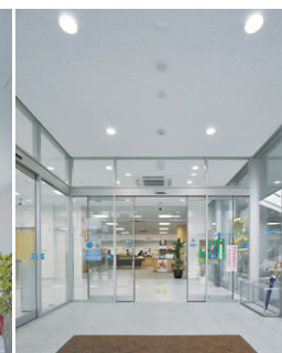
LEDダウンライトによる風除室の照明
