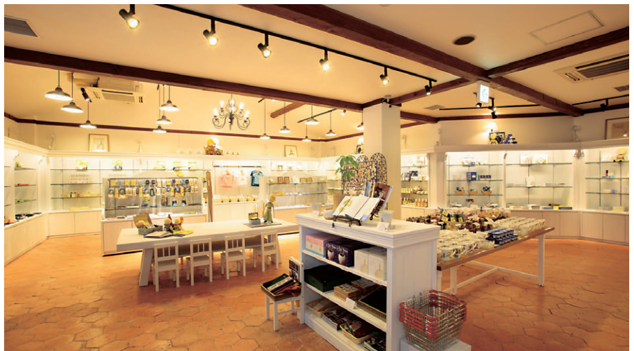
ミュージアムショップの照明 LED電球スポットライトと電球形蛍光灯ランプ用特注ペンダントを採用し、明るい雰囲気演出
