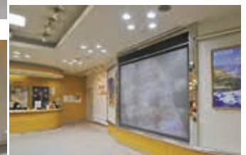
LED照明により鉛直面の明るさを確保
