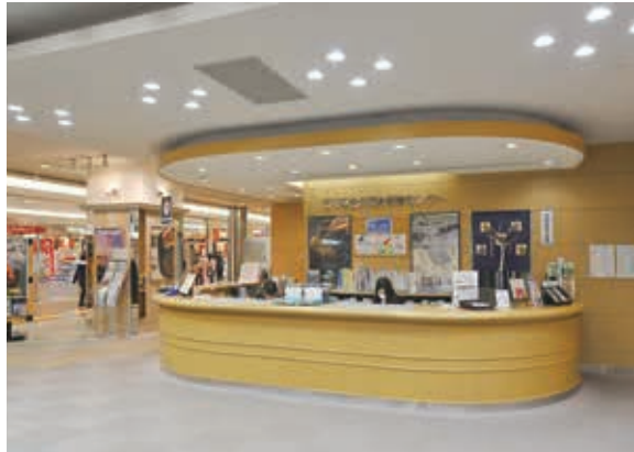
案内・カウンター周りのLED照明
