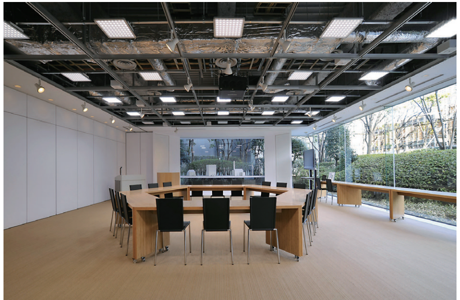
照明がオールLED化されたコミュニケーションプラザ (LEDベースライト、LEDダウンライト、LEDスポットライト全点灯時)
