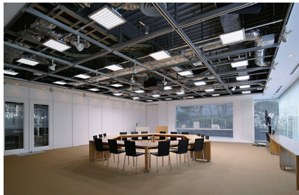
会議・セミナーモードの点灯状態 (LEDベースライトのみ全点灯時)
