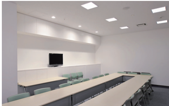
ボランティア室兼休憩室 LEDベースライト埋込形スクエアタイプと壁際のLEDダウンライトにより部屋全体の明るさ感演出
