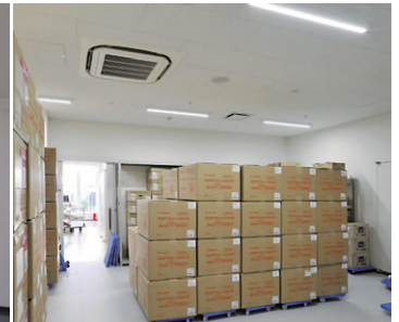
採血資材室 LEDベースライトストレートタイプと人感センサとの組合せで衛生面と省エネを配慮
