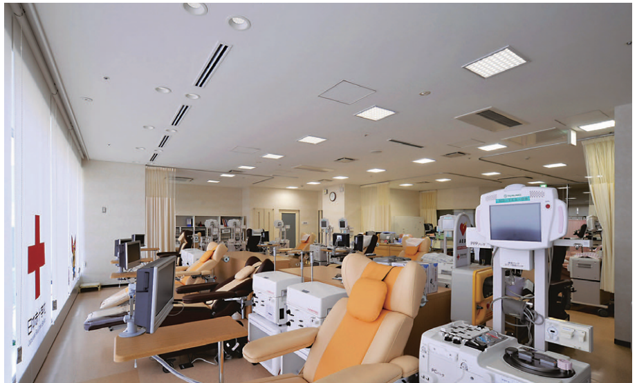
採血室 ベース照明には高効率でグレアレスのLEDベースライト埋込形スクエアタイプを、窓際の採血椅子にはLED調光ダウンライトと照度センサによる適正照度制御を採用
