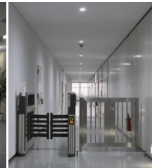
館内通路のLEDダウンライトは人感センサで制御
