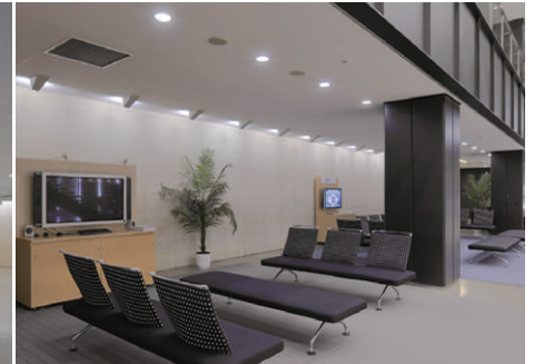
1階ロビーは、壁際のLED電球を使用した間接照明と天井のLEDダウンライトで明るさを確保
