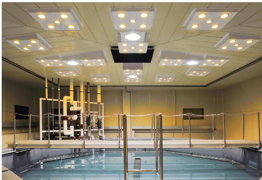
LEDダウンライト5台を照明ボックスに納めたものを水槽1基に対して16セットを配置。様々な照明パターンを組み、自然に近い毎日のスケジュール制御を駆使
