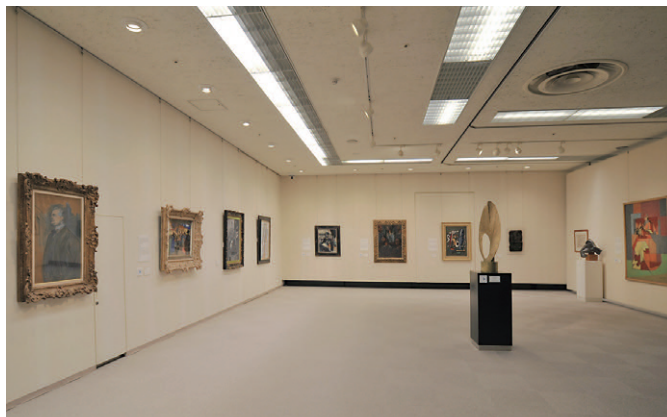
壁際のダウンライトを全てLEDダウンライトに更新
