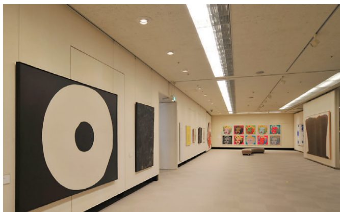
円形バツフルを使用して壁面にとどく無駄な光をカットしている
