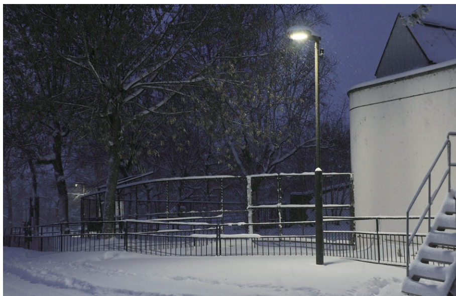
園路照明を250Wメタルハライドランプ街路灯からLED街路灯に更新し、安全・安心な明るさを確保しつつ、大幅な省エネを実現
