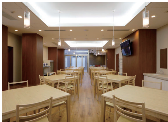
食堂の照明 折り上げた天井中央の間接照明の周囲にLEDダウンライトを配置。間接光との光色のコントラストでより高く開放的な空間を演出
