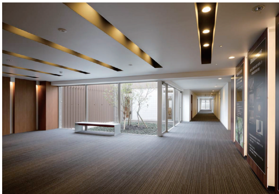
ロビーの照明 天井スリット内にLEDダウンライトを収め、その陰影により天井及び壁面の造作を際立たせ、かつ不快なグレアを抑制して快適な空間を演出
