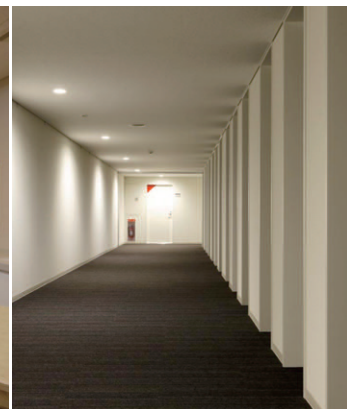
LEDダウンライトを壁面に沿って配置することで、明るさ感も誘導効果も高めた廊下の照明
