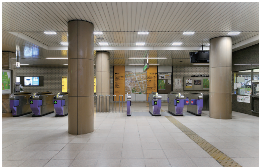
改札口天井の照明 水銀ランプダウンライトを撤去し、LEDベースライトを設置。初期の余剰な明るさを抑えるため、通常は60%調光を実施
