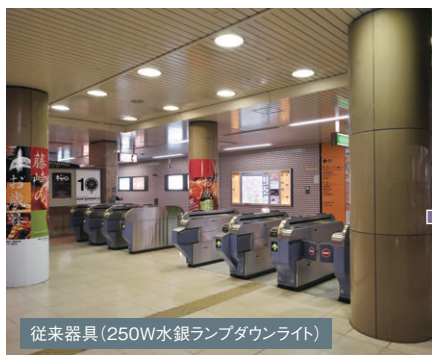
改札口天井の照明 水銀ランプダウンライトを撤去し、LEDベースライトを設置。初期の余剰な明るさを抑えるため、通常は60%調光を実施
