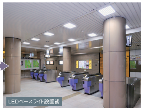
高効率LED照明により、消費電力は従来比約78%削減
