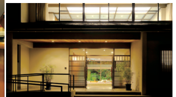
夜景 玄関軒下にLEDダウンライトを採用し、省エネ、CO 2 低減、そして低誘虫に配慮
