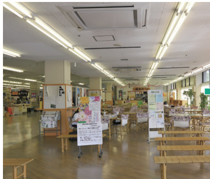
更新前のFLR110W器具による市民交流サロンの照明
