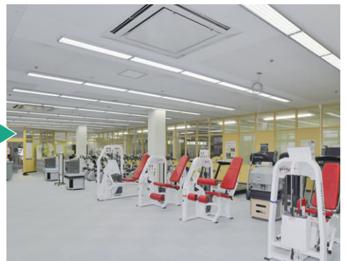
更新後のLEDストレートタイプによる健康づくりセンターの照明
