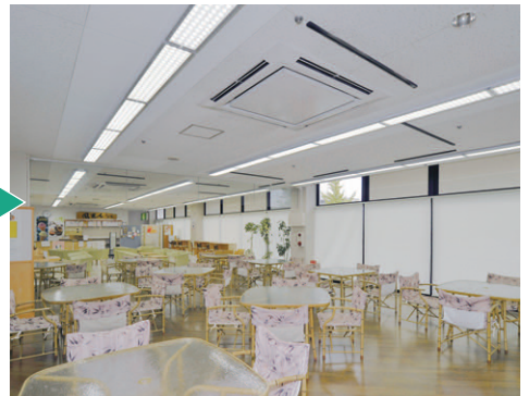
更新後のLEDベースライトによる市民交流サロンの照明
