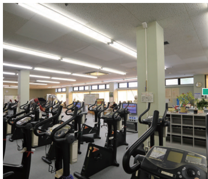
更新前のFLR110W器具による健康づくりセンターの照明
