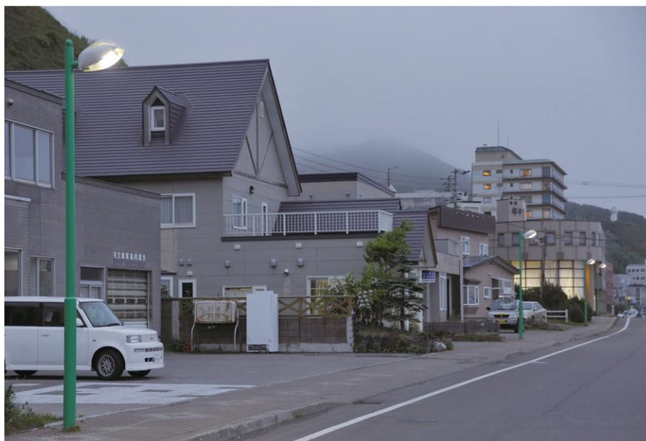
歩道側に片側配置で20mから35mピッチにして設置された更新の特注LED街路灯
