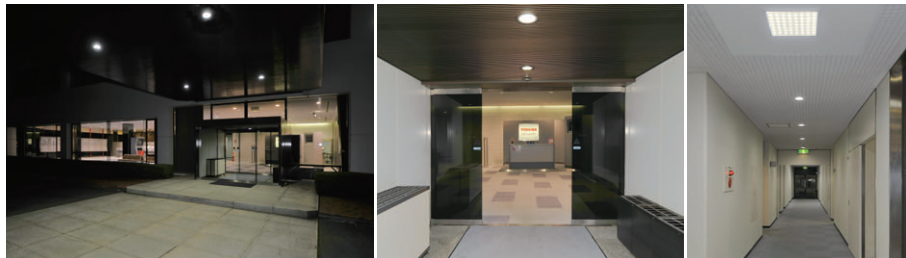
12号棟車寄せ軒下の照明 LEDダウンライト 軒下用を採用
