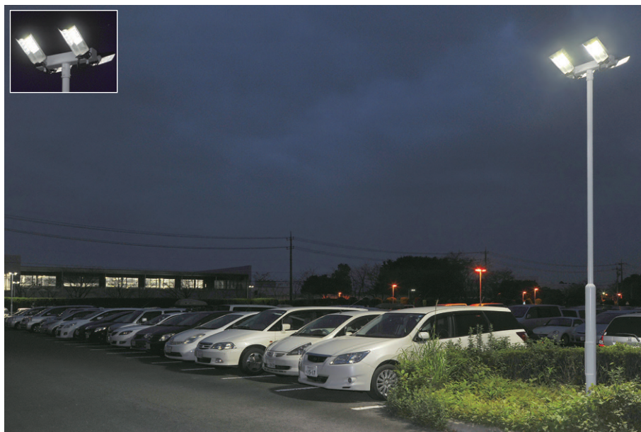
屋外駐車場の照明 ナトリウムランプ街路灯からLED防犯灯に更新 日没の点灯から日の出の消灯までをタイマー制御
