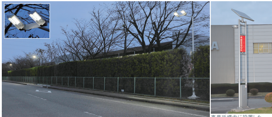
事業所構内と駐車場を隔てる道路に向けて設置された歩道用照明のLED防犯灯
