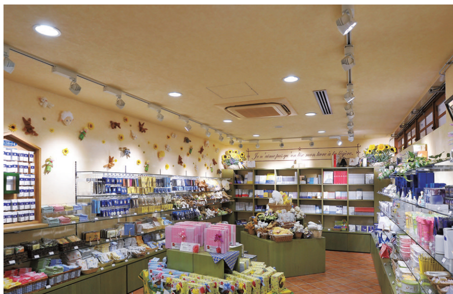
ショップの照明 ベース照明のLEDダウンライトと商品棚に向けたLEDスポットライトにより商品を際立たせ、魅力的な売場を演出
