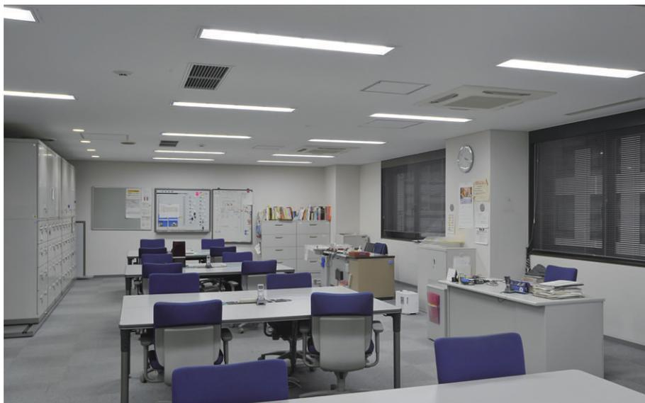
8階オフィスの照明 40W蛍光灯2灯用埋込器具からLED一体形ベースライトストレートタイプに更新し、消費電力53%を削減
