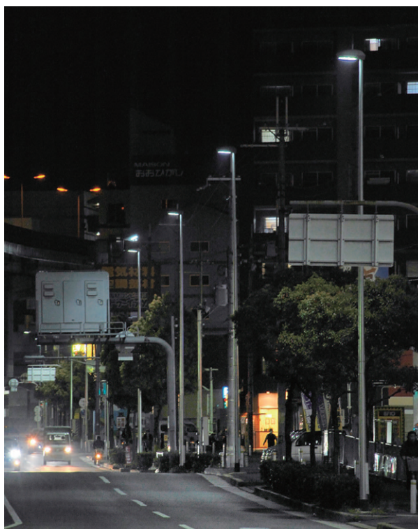
10m高さのLED道路灯照明柱を35~40mの間隔で設置
