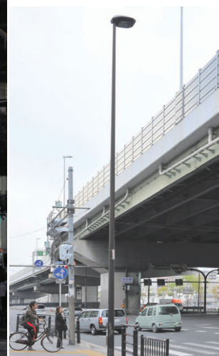
照明柱10m高さのLED道路灯
