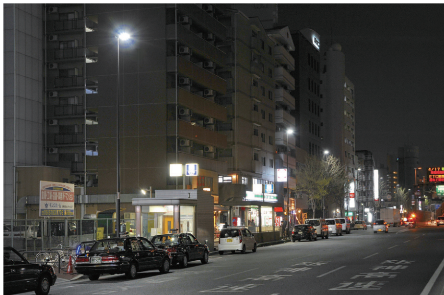
高圧ナトリウムランプ道路灯からLED道路灯に更新し、約55%の省電力を実現
