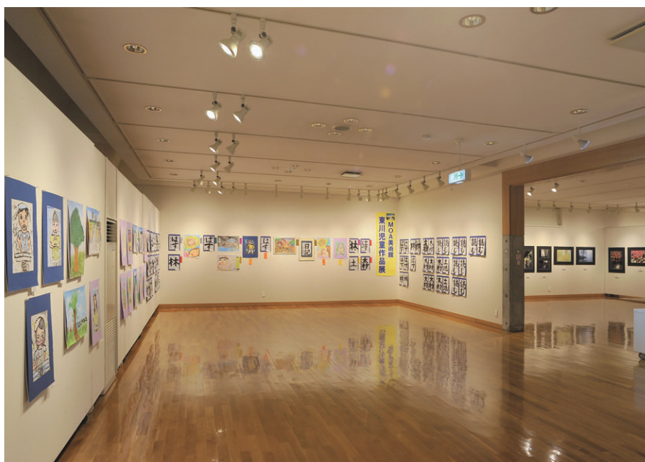
第1展示室の展示照明 ミゼットレフランプスポットライトから光源のみをLED電球に更新
