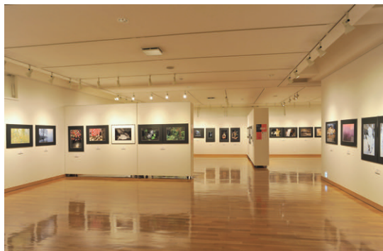
スポットライトをLED電球（昼白色と電球色の混光）に更新した第2展示室
