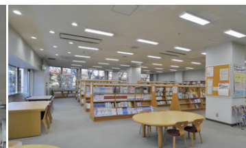
児童図書コーナーの照明 LEDベースライトの他、窓側の天井には光バランスを配慮LEDダウンライト900シリーズをレイアウト
