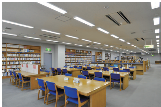
書架の照明 LEDベースライトの広角配光形を使用し、鉛直面照度を高めて本の背文字を読み取りやすい光環境を創出
