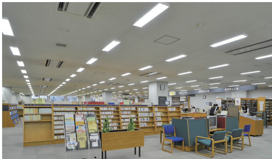
図書館フロア全体の照明 高さ3mの天井のほぼ全面にLED一体形ベースライト直付形ストレートタイプを採用し、消費電力を大幅に削減
