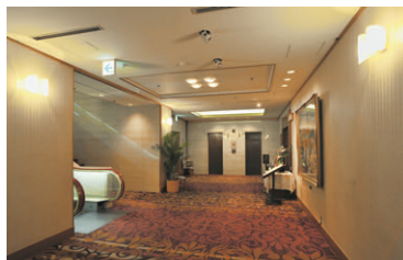
エレベーターホールのLED照明 ダウンライトとブラケットの光源をLED電球に更新
