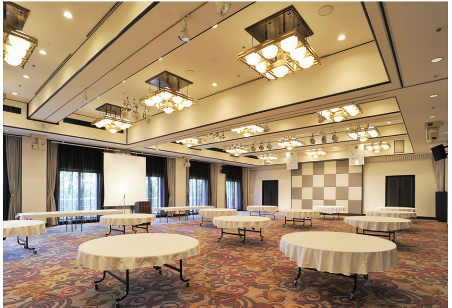
LED照明に更新された大宴会場「大和の間」 シャンデリアにはLED電球を、その周辺にはLEDダウンライト2000シリーズを採用
