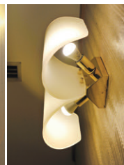
LED電球に置換えたブラケット
