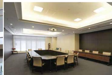
役員会議室の照明 ベースに乳白色パネルのスクエアLED照明、演出照明にLED内蔵建築化照明、補助照明にLEDダウンライトを設置
