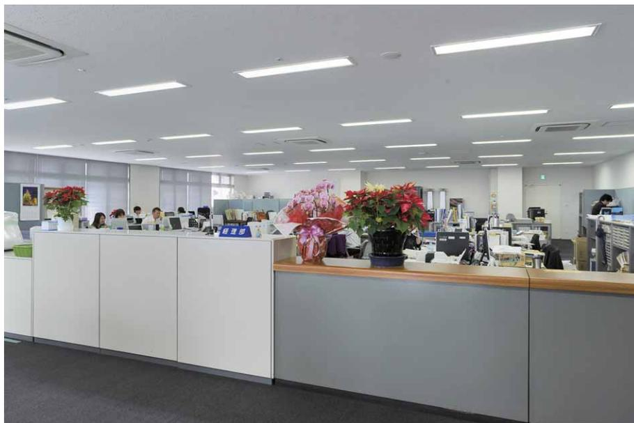
オフィスフロア執務室の照明 一体形LEDベースライト埋込形拡散カバータイプを採用し、まぶしさを抑制した快適な光環境を確保しつつ、大幅な省エネを実現
