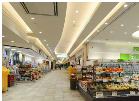
通路のLED照明は店舗内の明るさより少し暗めにし、誘導効果を高めている
