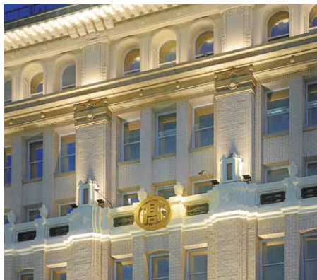
正面玄関口の真上6階の外壁に6台の小形投光器を配置
