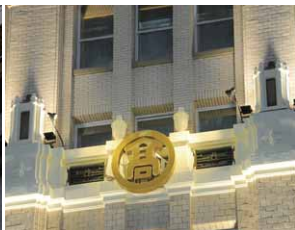
ブランドシンボルマークを左右から照らすLED電球ビームランプ形を装着したスポットライト器具
