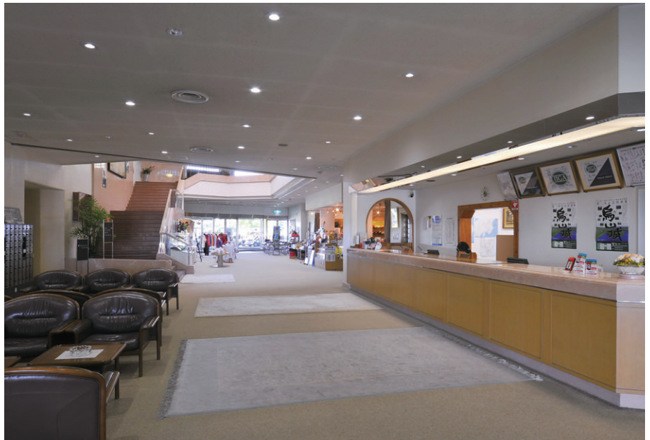
1階ロビーの照明 E-CORE100とE-CORE60を交互に配置し省エネを実現、メンテナンスの手間を省きつつ、明るさ感を創出
