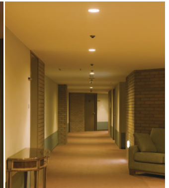
客室廊下は3mピッチでE-CORE40を設置
